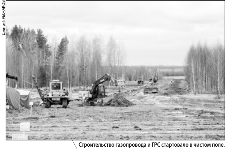
Строительство газопровода и ГРС стартовало в чистом поле.
