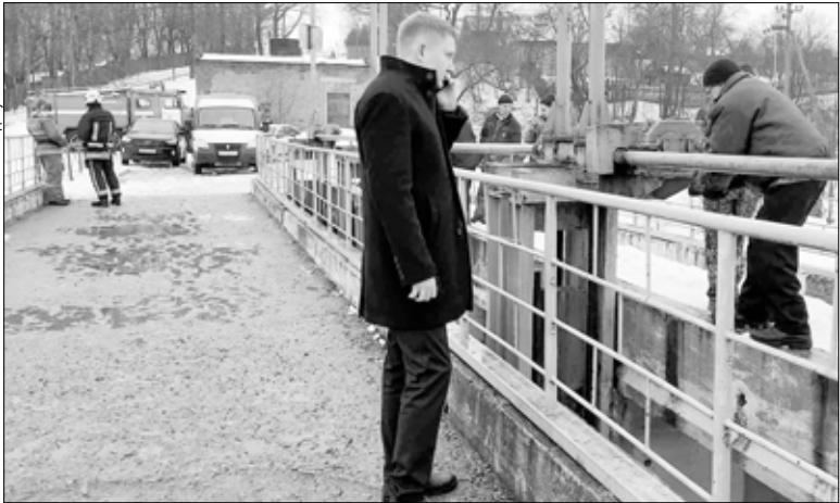
Плотина в Лежневе после ремонта.
