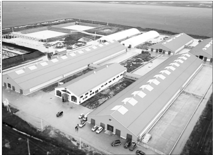
Благодаря новым объектам, Гаврилово-Посадский район становится центром животноводческой отрасли региона.
