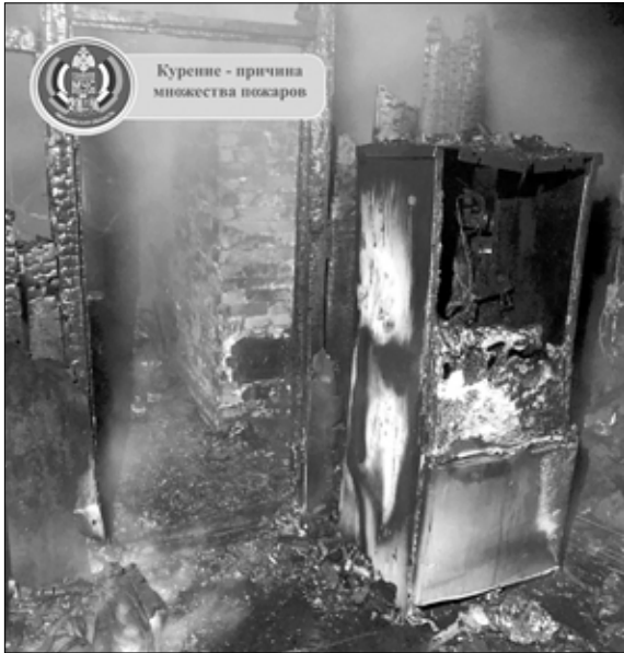
Причиной несчастья стала непотушенная сигарета.
