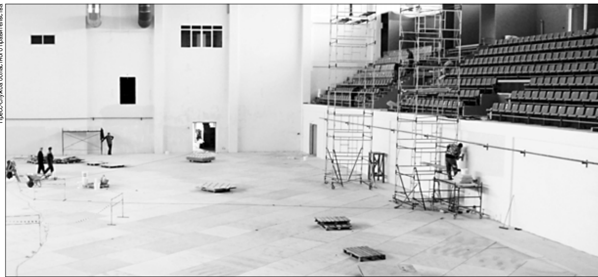
В спортивном блоке дворца завершается внутренняя отделка.
