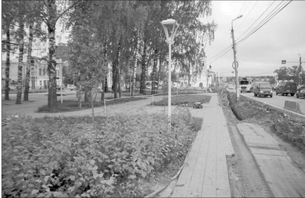
Завершить работы по благоустройству центральной площади Шué власти планируют к середине октября — на месяц раньше срока, обусловленного контрактом.
