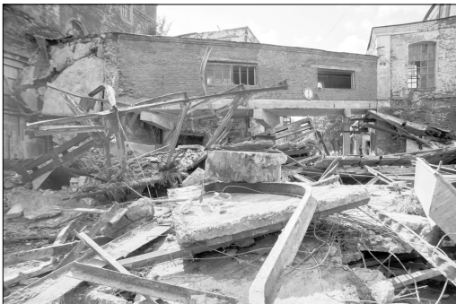
▲ Масштаб разрушений очень велик.
