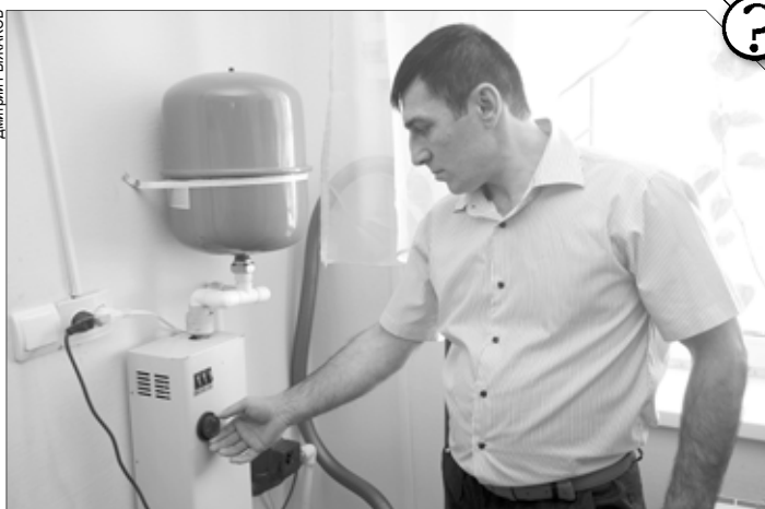
Котел можно будет включить только после принятия работ комиссией.
