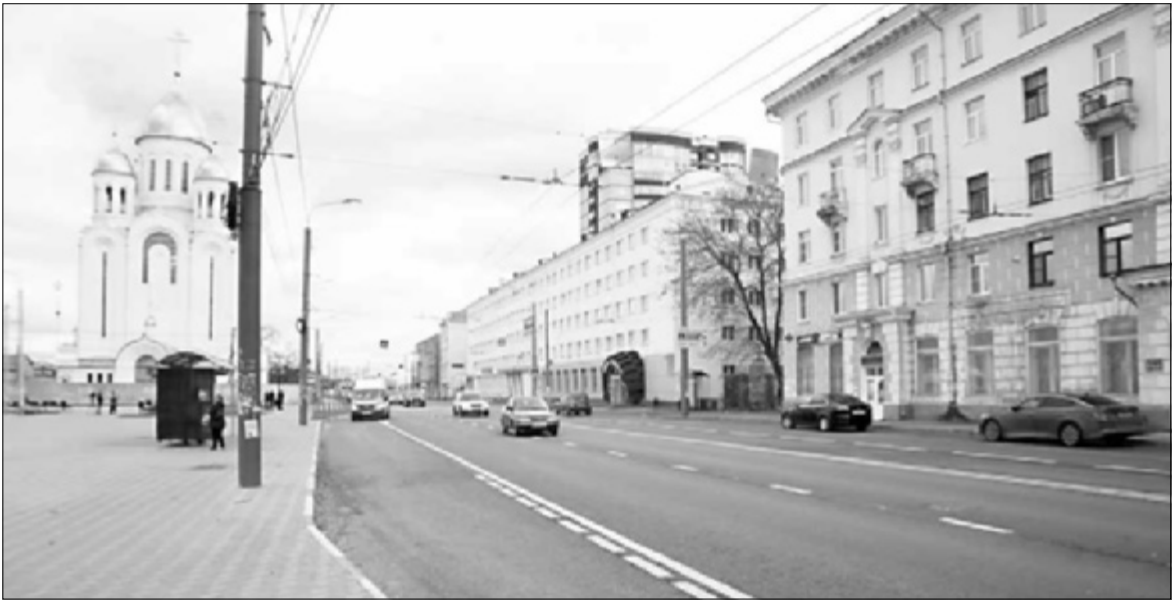
▲ Строительству и ремонту дорог власти области уделяют повышенное внимание.
