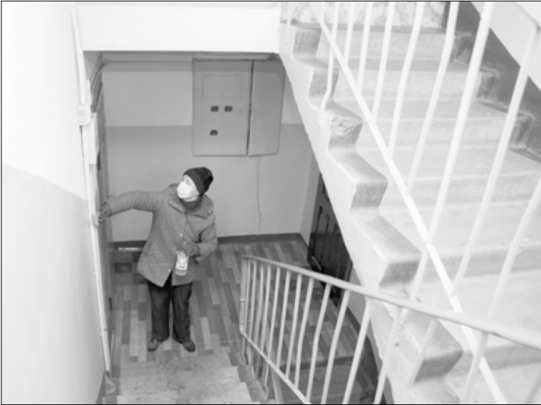
Требования к дезинфекции подъездов постоянно ужесточаются.
