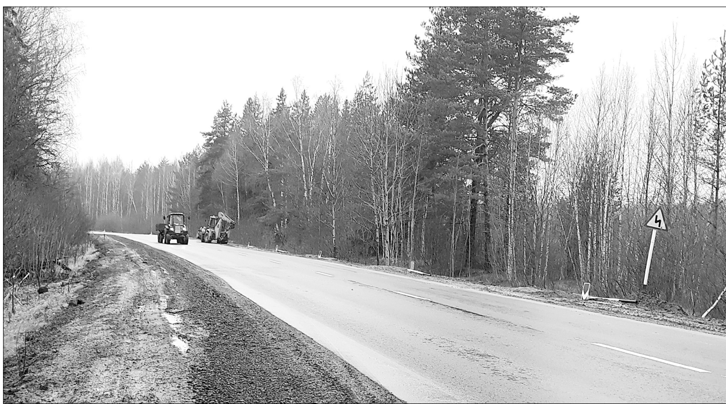
▲ Осталось установить дорожные знаки.
