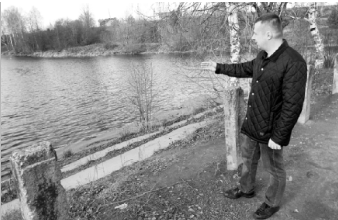
Александр Кудряков показывает водохранилище с плотиной.
