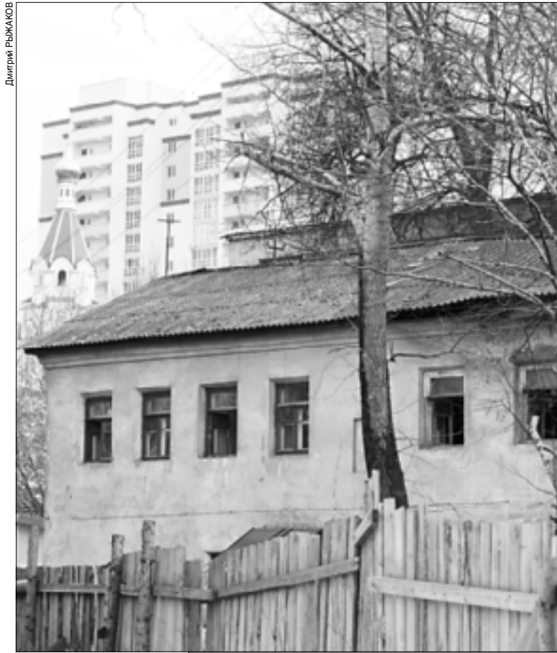
Аварийное состояние жилья – повод встать в очередь.
