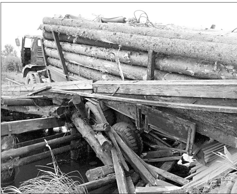
▲ Очевидцы сфотографировали мост сразу после его обрушения.
