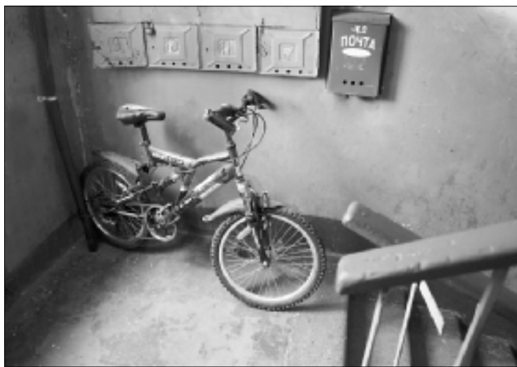
Захламление подъездов может привести к трагедии при пожаре.
