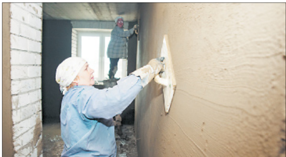
В штукатурках только женщины.
