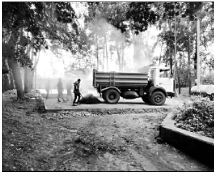
Строительство игровой площадки идет полным ходом.
