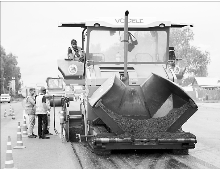
▲ Масштабные работы в Ново-Талицах идут полным ходом с участием нескольких единиц техники и дорожных бригад.
