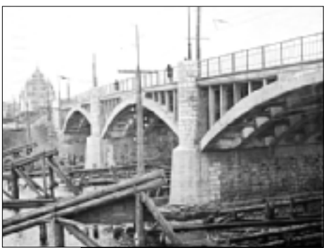
Железобетонный мост начал действовать в 1929 году.
