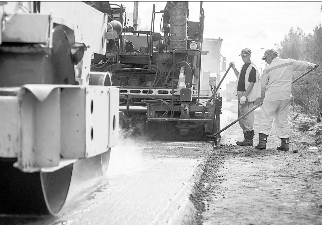
▲ На федеральные средства в области планируется отремонтировать 119 километров автодорог.
