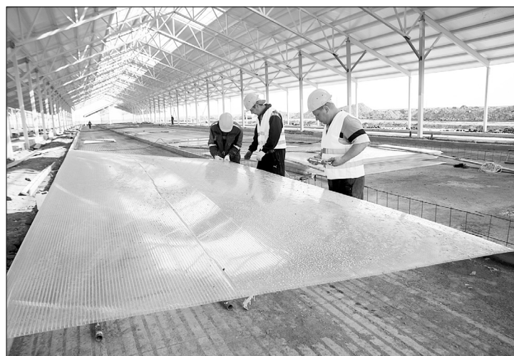
▲ Строители готовят специальную пленку для световых козырьков, которые установят на крыше.
