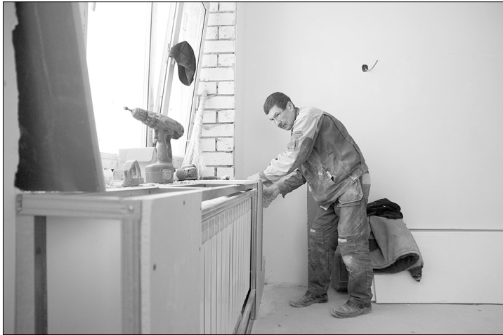
▲ Строители внутри здания работают с утра до вечера.
