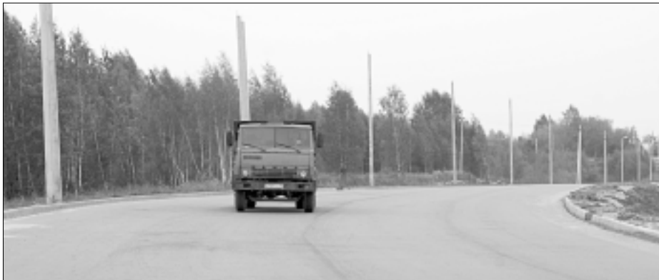
На Кострому можно будет проехать, минуя центр Иванова, выехав в районе Северного аэродрома.
