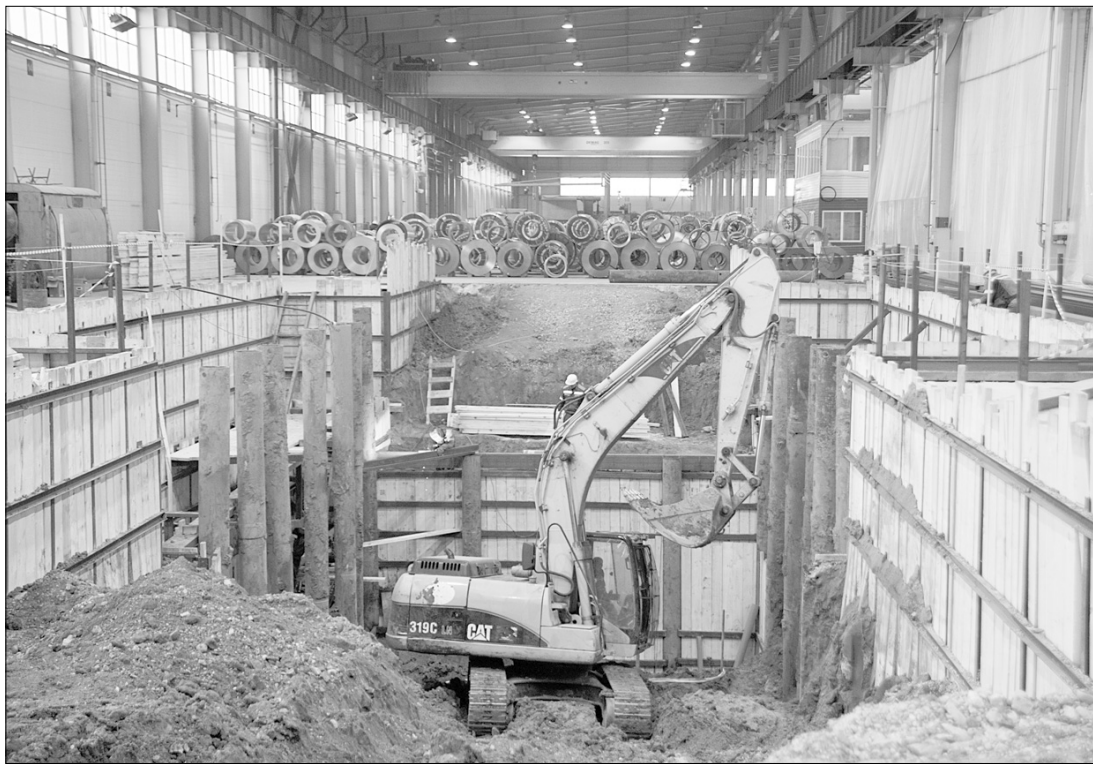
▲ Крупный инвестпроект по созданию четырех новых производственных линий требует масштабного строительства.
