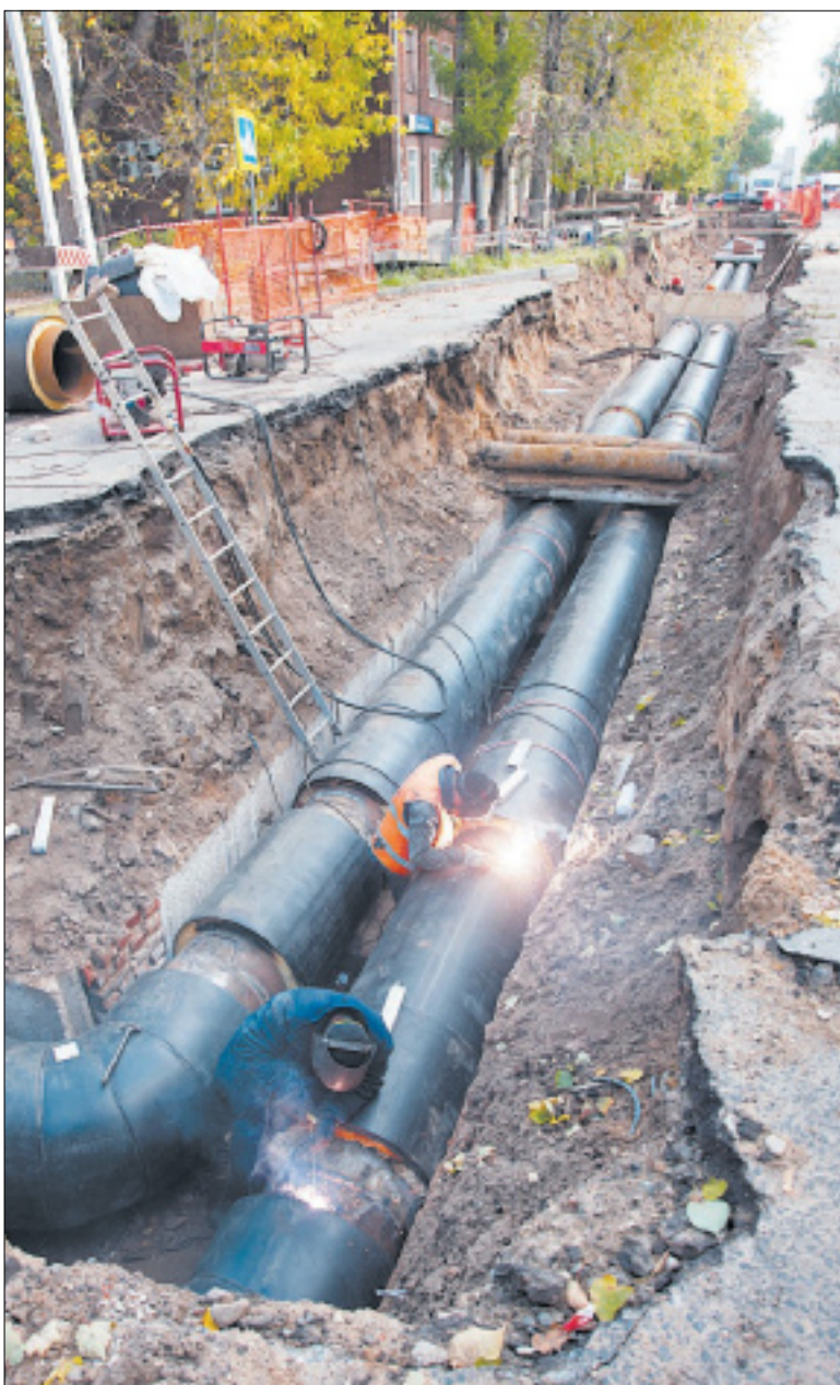
В этом году энергетики «Т Плюс» заменили в Иванове 3,5 километра тепловых сетей.
