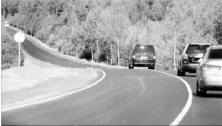
▲ Ремонт автодороги Палех — Шуя выполнен с применением новых технологий.
