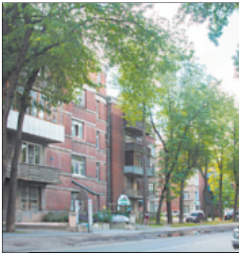
Два дома на Комсомольской достраивали с помощью автомобильных домкратов.
