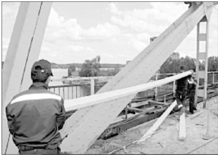
Активно идет второй этап ремонта Никольского моста.
