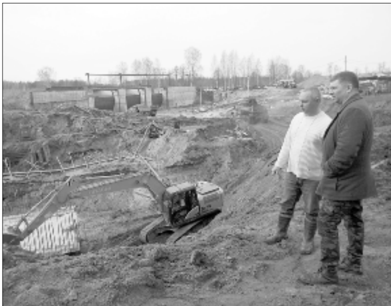
Главный инженер «Верхне-Волжскводхоза» Андрей Кузнецов и прораб Иван Андреев на стройке Польковского гидроузла № 2.
