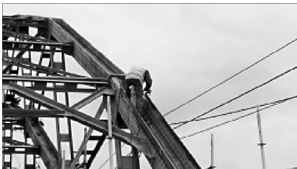
Реконструкция моста продолжается.
