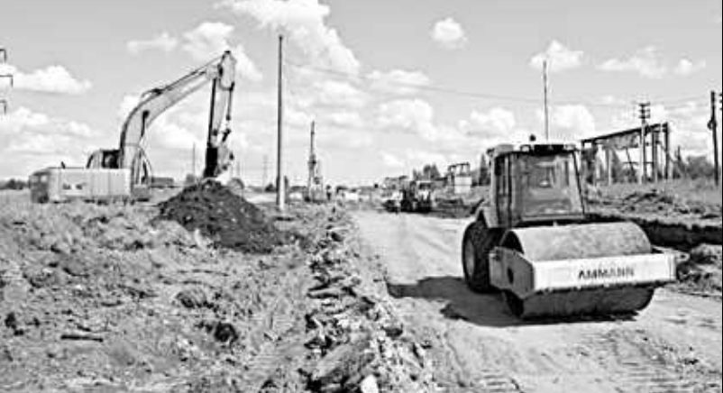
▲ На улице Станкостроителей идут дорожные работы.
