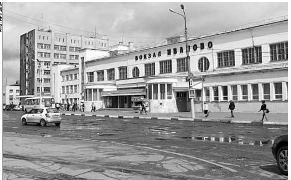
Дорога у вокзала тоже требует ремонта.
