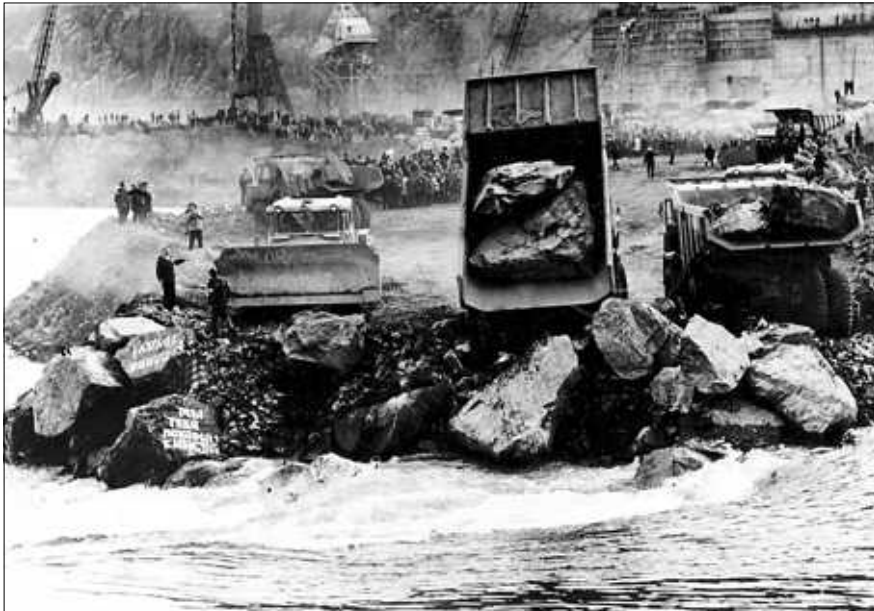
Начало строительства Красноярской ГЭС.
