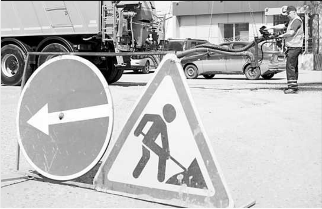
▲ В Иванове показали ремонт дороги методом пневмонабрызга.
