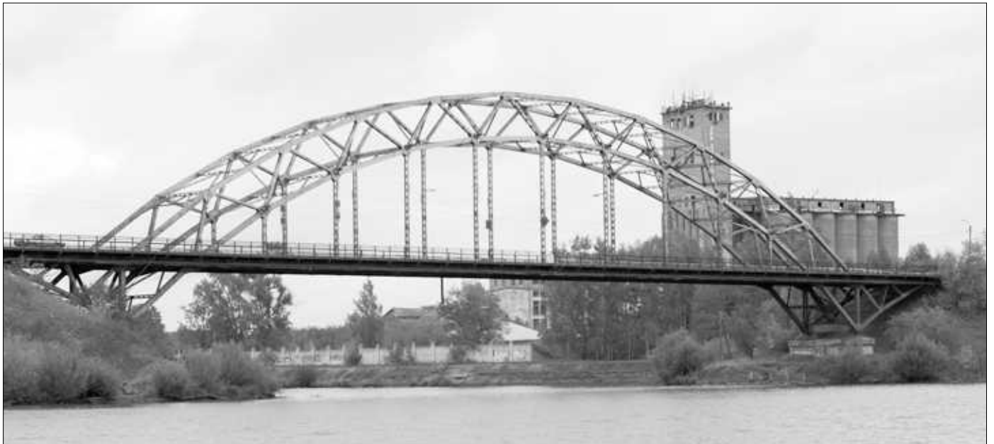
Капремонт Никольского моста в Кинешме проведут в этом году.
