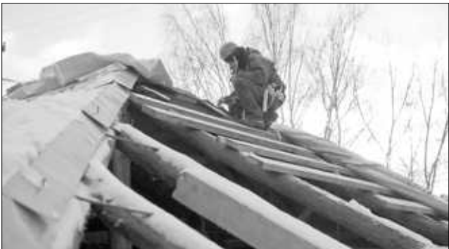
Кровля вскрывается небольшими кусками.
