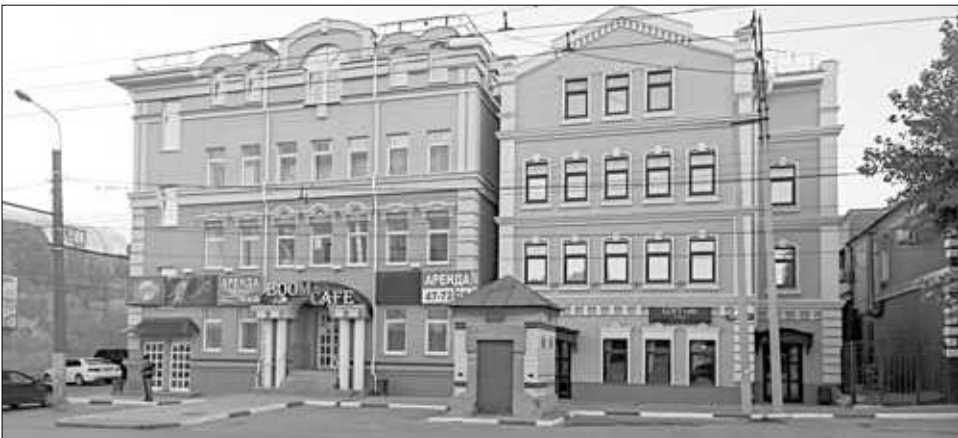
Трансформаторная подстанция сохранилась и на улице Смирнова.
