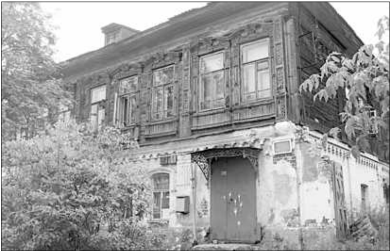
Здание горстатистики не ремонтировалось с советских времен.
