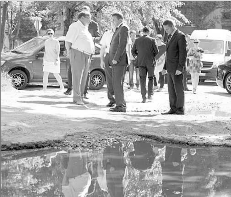
▲ Улицы в Красных Сосенках будут ремонтировать в первую очередь.
