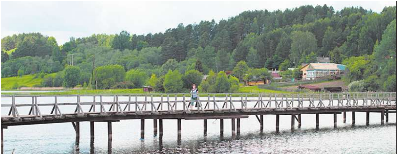
Пешеходный мост через Сунжу.
