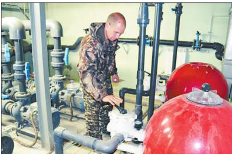
Так выглядит внутренняя часть сооружения.
