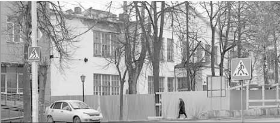
Бывшее здание исторического факультета пошло под снос.
