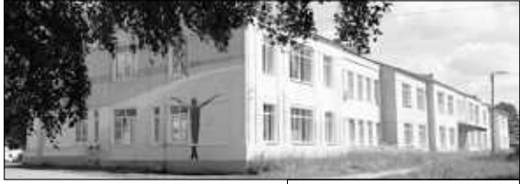
Главный корпус ЦРБ.
