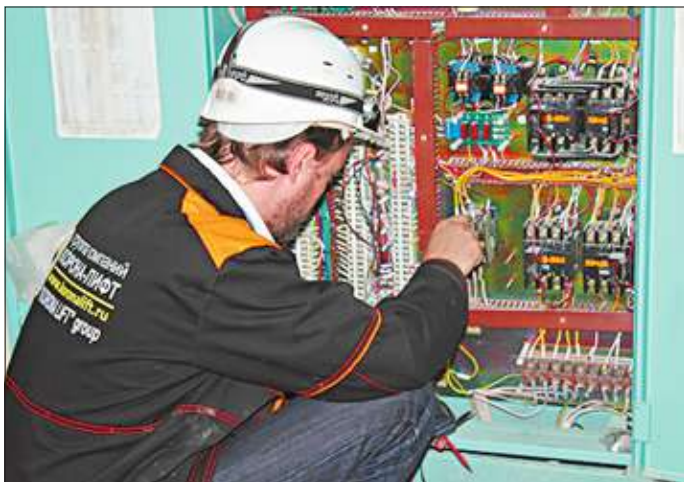
Монтаж нового диспетчерского комплекса.
