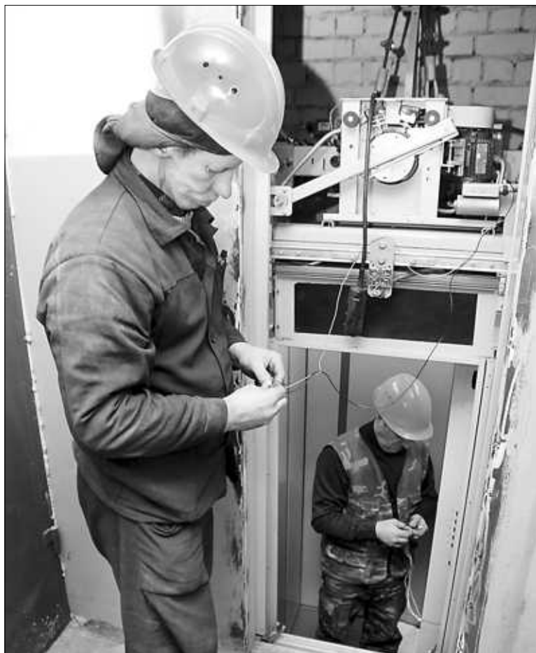
При неисправности подъемника меры должна принимать «управляшка».
