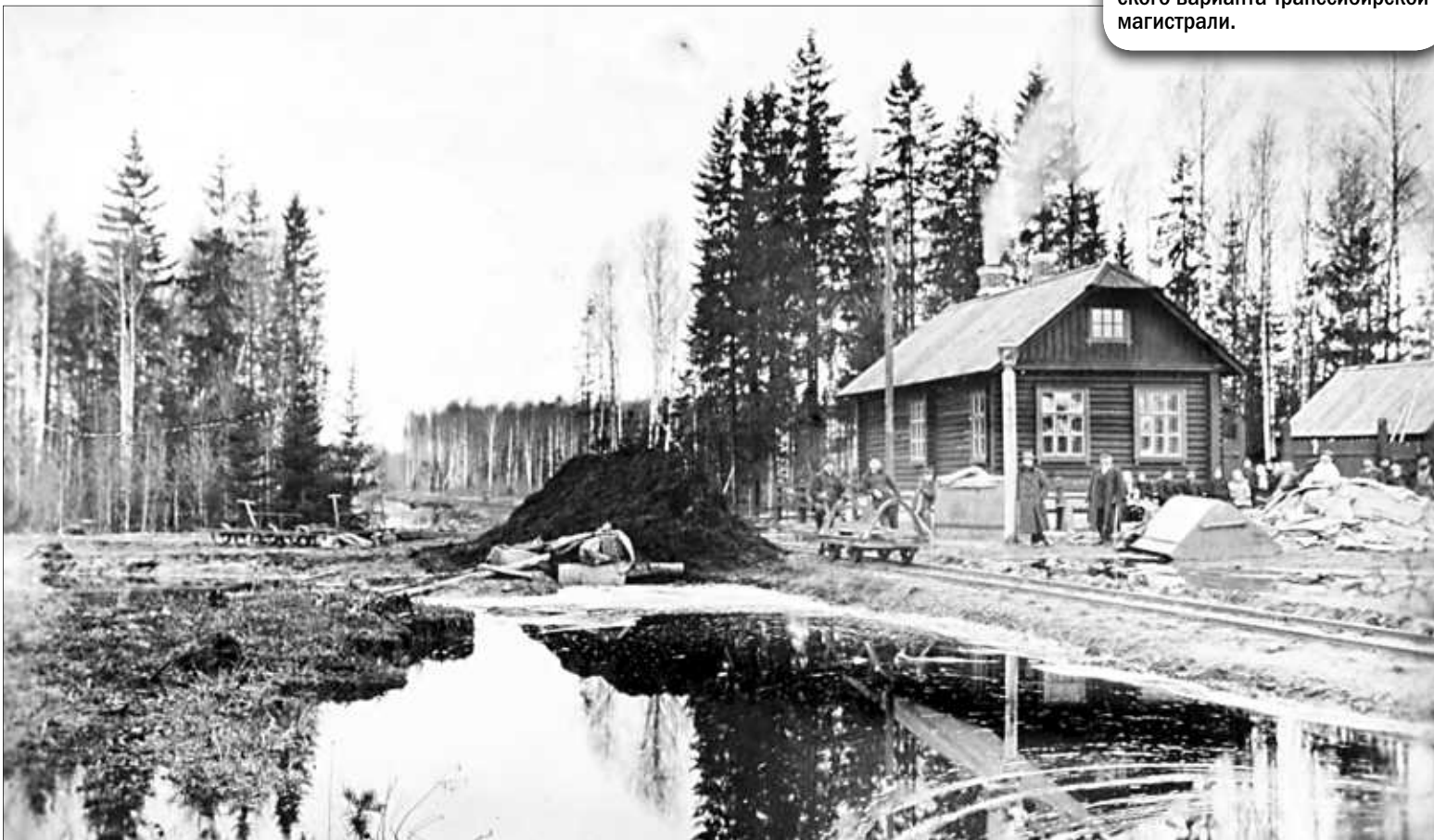
Строительство узкоколейки от Южи к Клязьме в 1915 году.
