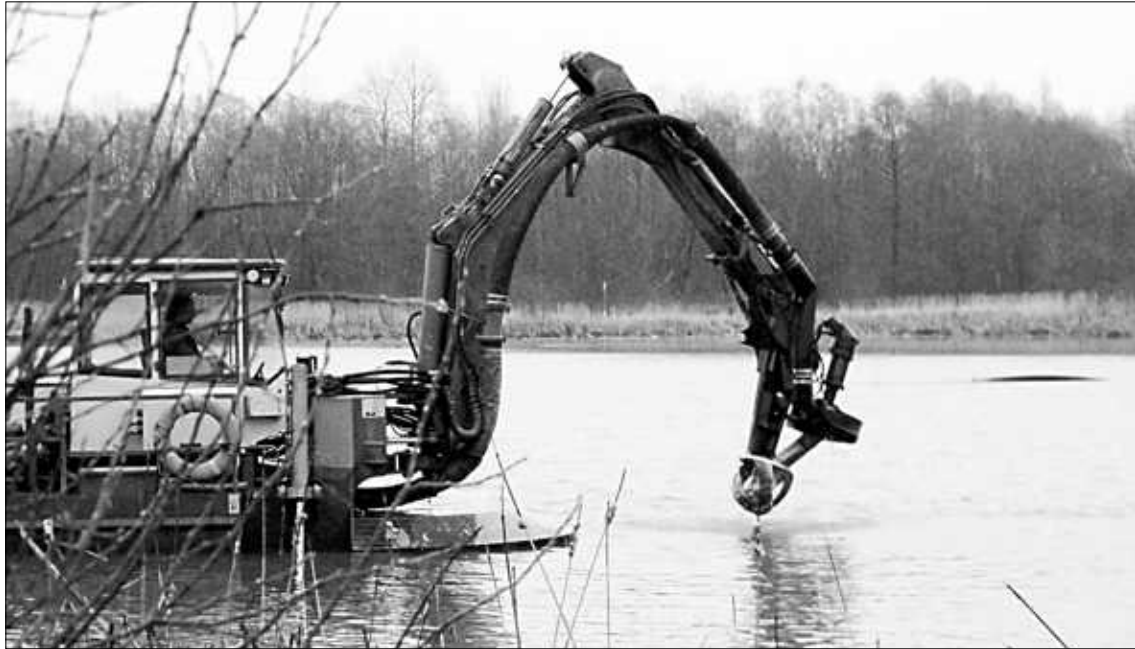
▲ Земснаряд поднимал со дна Вергузы уже около 60 тысяч кубометров грунта.
