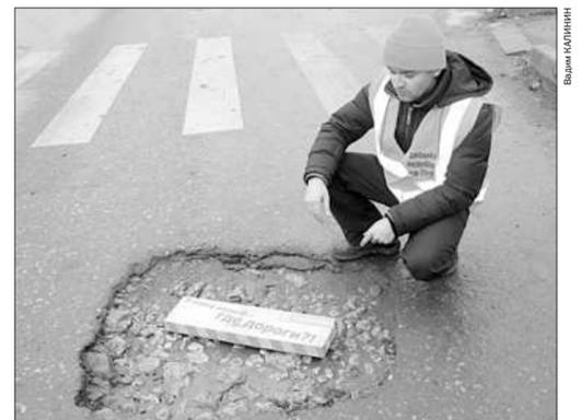
▲ Недопустимые ямы на дороге можно измерить самодельной «кабалашкой» — деревянным брусом размером 65x15x5 см.
