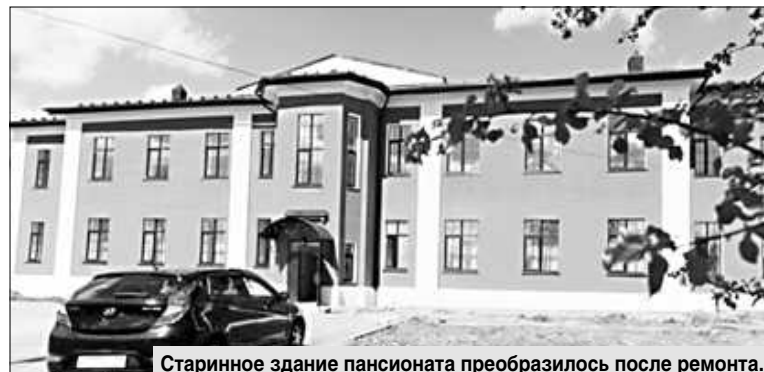
Старинное здание пансионата преобразилось после ремонта.
