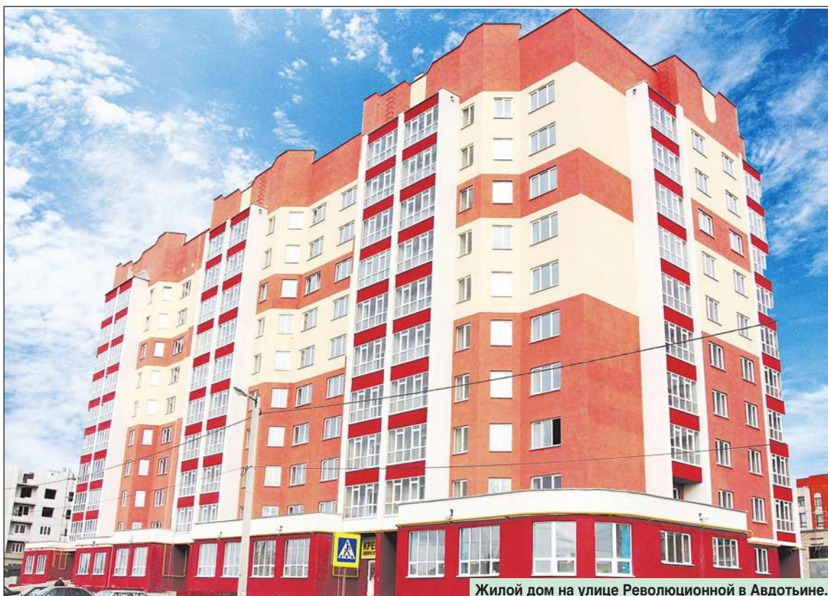
Жилой дом на улице Революционной в Авдотьино.
